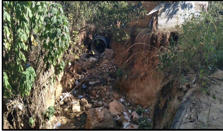
FIGURA N°03: TRAMO DE LA QUEBRADA KERMAN COLMATADO Y SIN LIMPIAR, EN EL SECTOR DE LA BANDA DE
